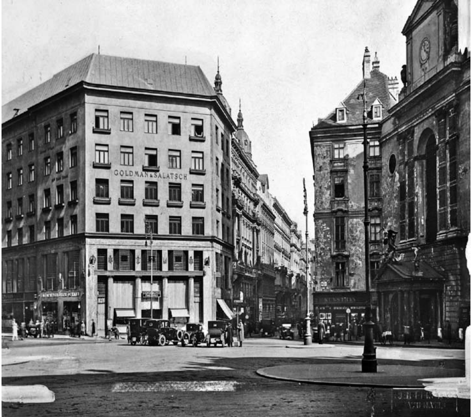
Abb. 2: Haus am Michaelerplatz, 1909-1911, Architekt: Adolf Loos
